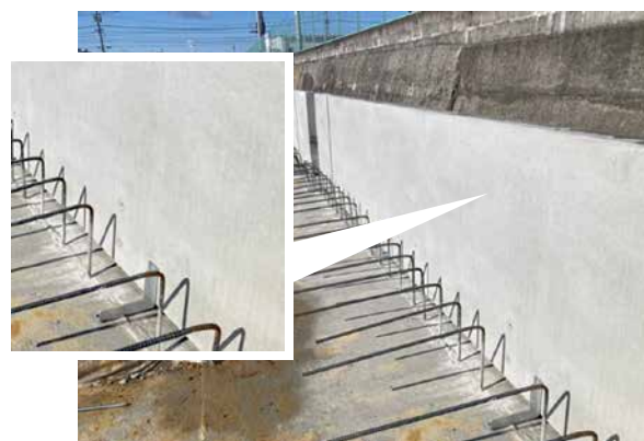
SKIRT PC 工法での仕上がり面
