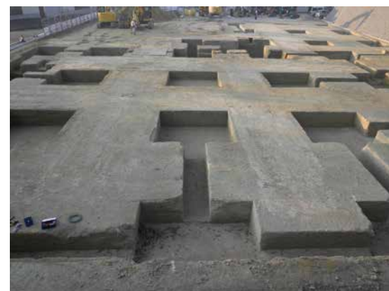
TNF工法採用の施工現場
