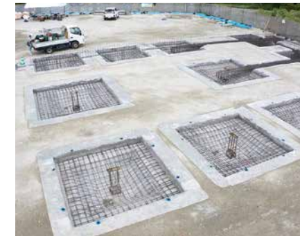
TNF-DD工法採用の現場写真
