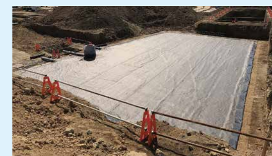
上部保護シート敷設
