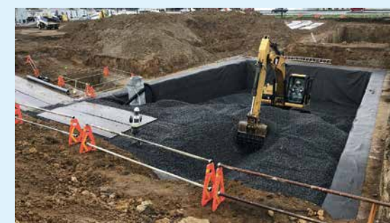
単粒碎石敷設
