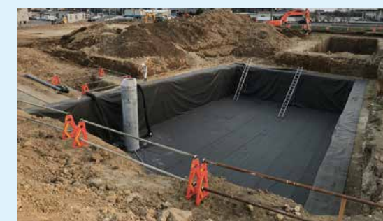
保護マット敷設・点検口設置
