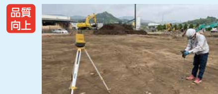
杭ナビを用いた、正確で効率的な測量
