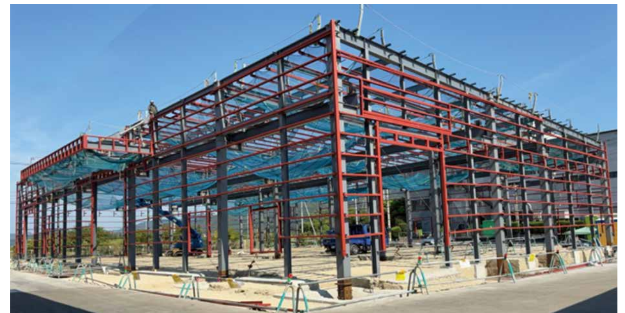
A Bolt less 工法採用の現場写真
