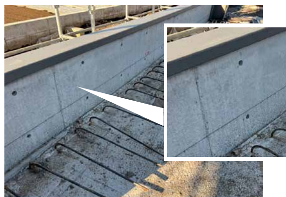
現場打ちでの仕上がり面
