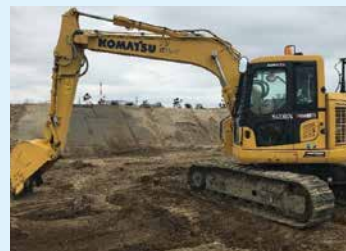
ICT建機を活用した施工
