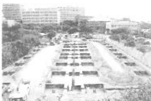
地盤改良の「TNF工法」は低コストが売り(施工例)
