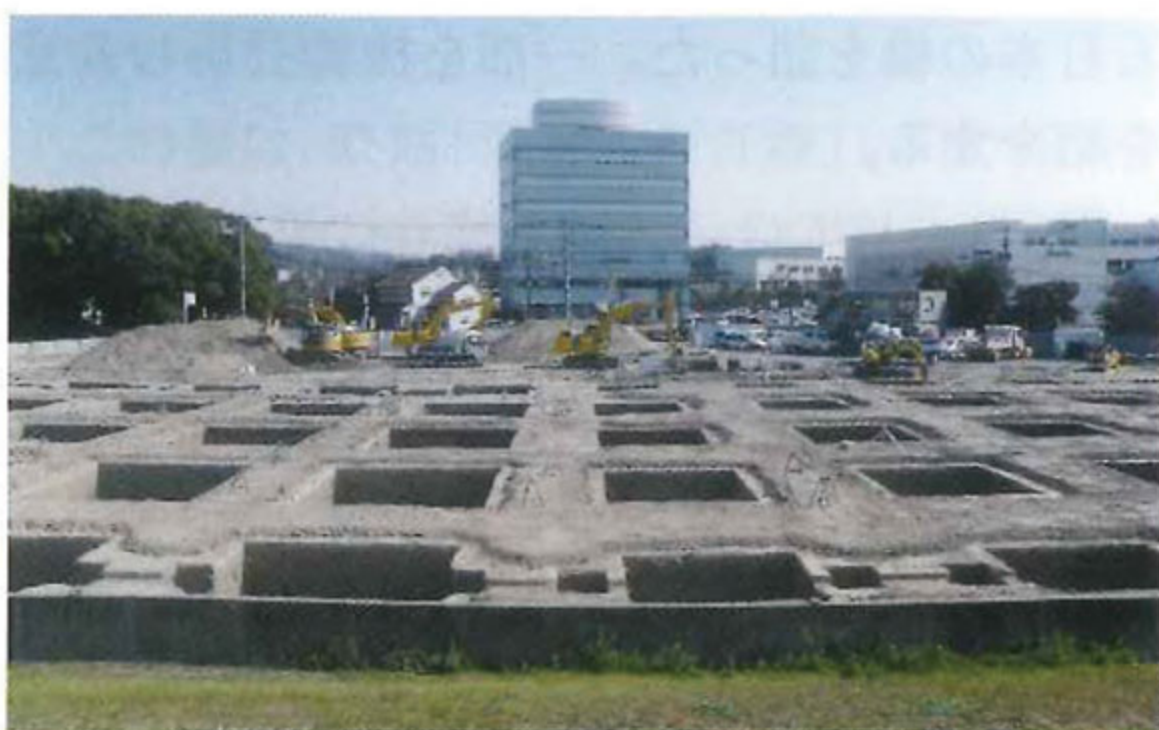
TNF工法施工現場
