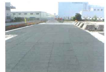
ジオテキスタイル敷き完了
