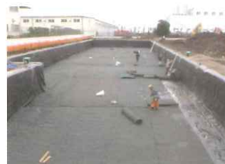
遮水シート敷き
