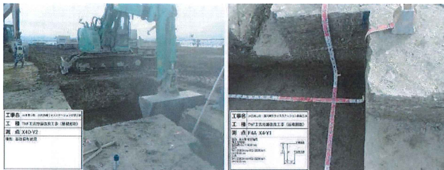
写真9 基礎掘削における鉛直の掘削壁面形成の様子
