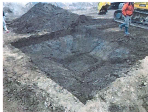
写真3 ICT搭載の重機による台形基礎掘削の様子
