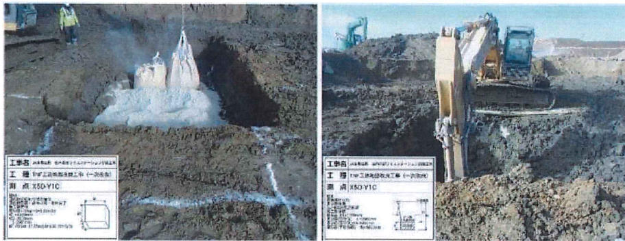
写真7 固化材散布, 攪拌の様子
