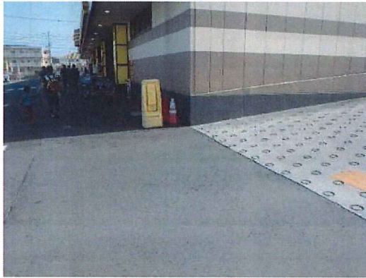
写真2 熊本地震発生数日後の様子
