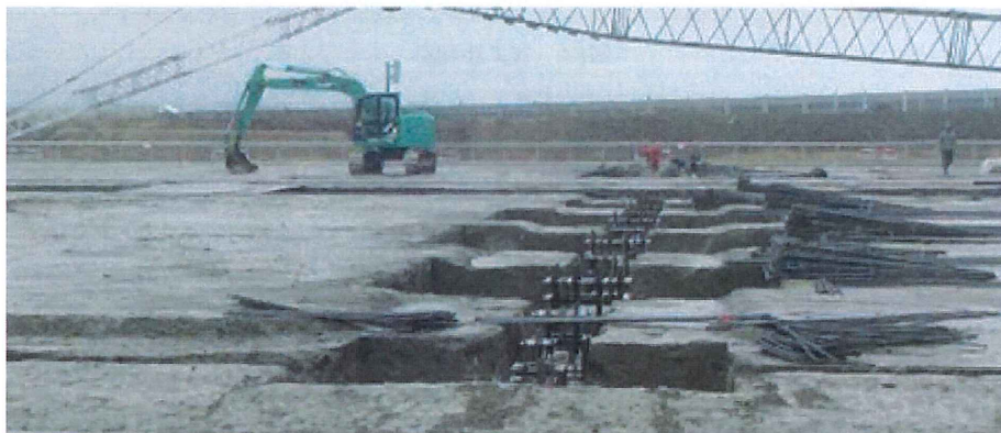
写真10 基礎掘削完了
