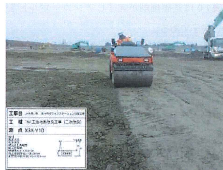
写真8 覆土養生実施の様子
