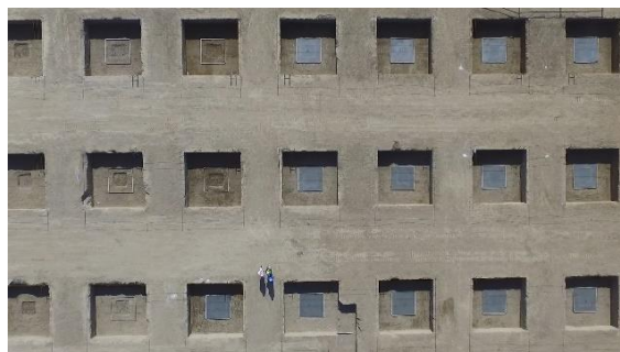
TNF 工法採用の施工現場(ドローン撮影)
